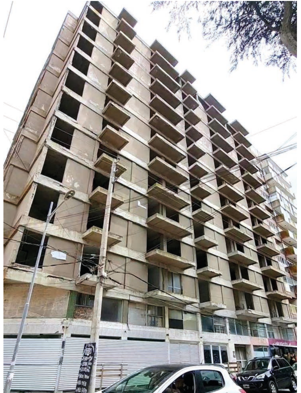
OBRAS REALIZADAS EN LA LOCALIDAD COSTERA DE SAN BERNARDO. FUENTE: ING. CLAUDIO VELAZCO
